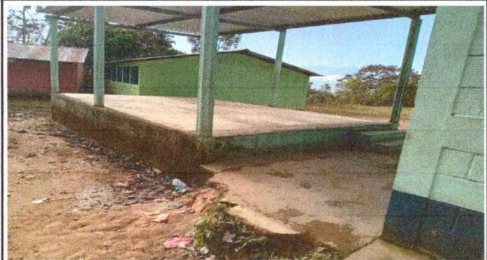
Foto 1: Se observa que ya está se empezó a remodelar el modulo 1, y el cambio del techo
